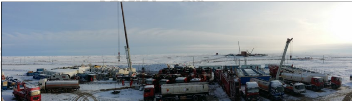
图2 玛131区块工厂化压裂现场图
